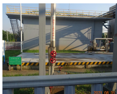
有机废水处理站
