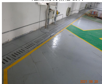
危废仓库导流沟、防渗地面
