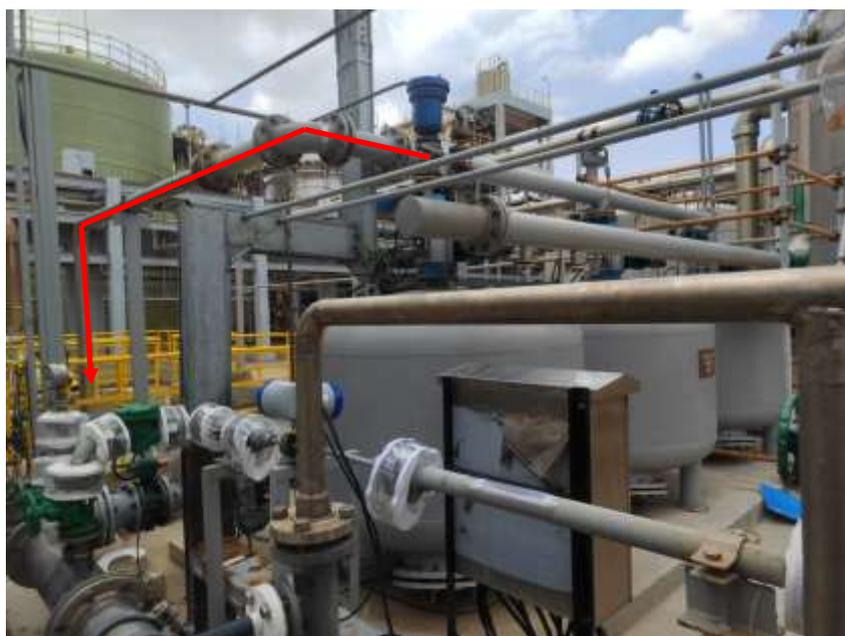
图 4.1-1 回收盐水管线（去化盐工序）照片
