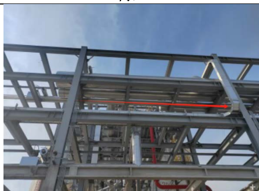
新建丙烷罐区至北厂区北厂界丙烷管线
