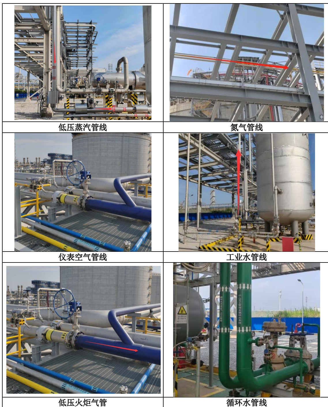
图 3.2-1 本项目一阶段已建成管线现场照片
