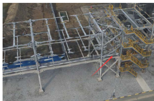
新建丙烷罐区至北厂区东厂界丙烷管线
