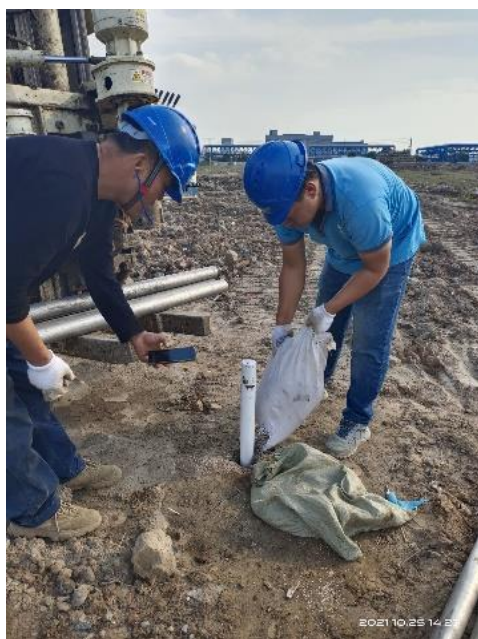
PVC 项目土壤前期调查
