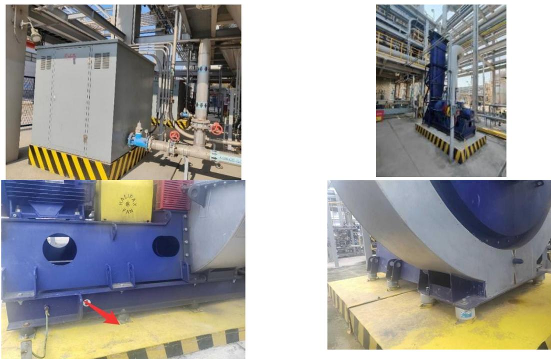
图 4.1.3-1 噪声治理措施现场图（减震措施）
