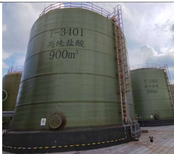
高纯盐酸储罐
