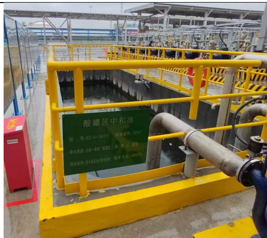
酸罐区中和池
