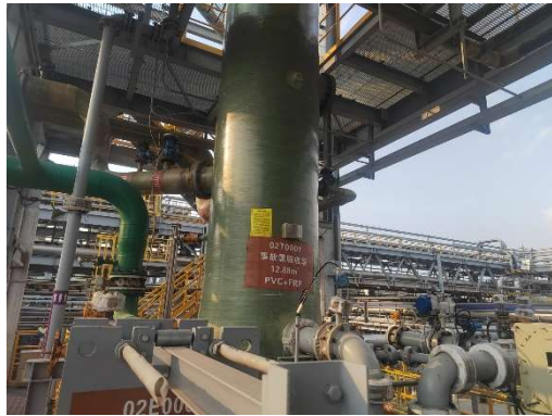
事故氯处理系统（本次新建的两塔及管线）
