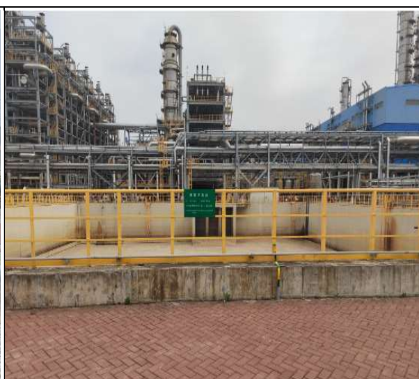
烯烃厂区事故池
