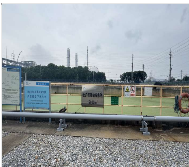
北厂区事故池
