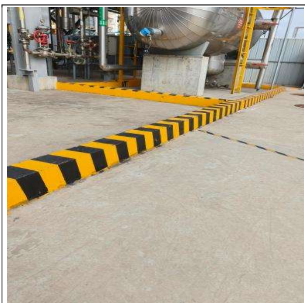
中试装置区地面防渗措施
